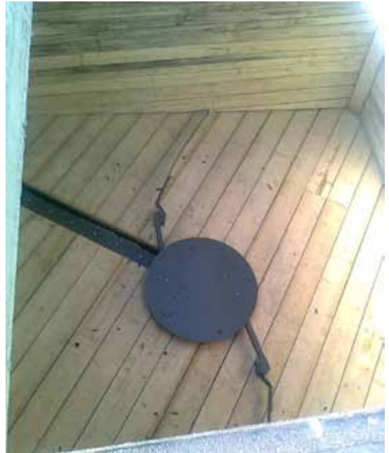
Stazione Forestale Tarvisio: deposito cippato agitatore a pavimento con braccia articolate
